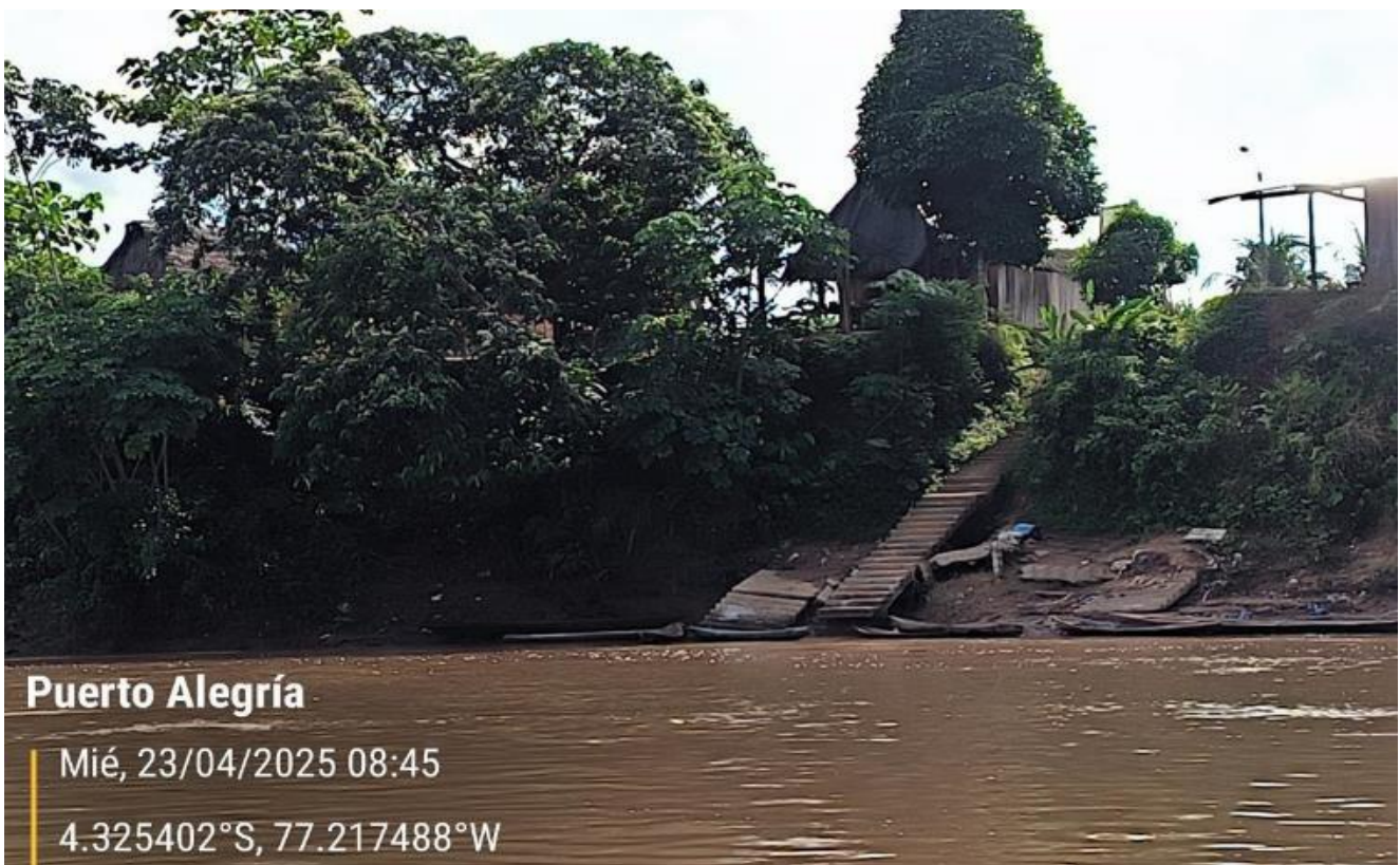
FIGURA N°02: ESCALERA PEATONAL AFECTADO POR LA EROSIÓN.
